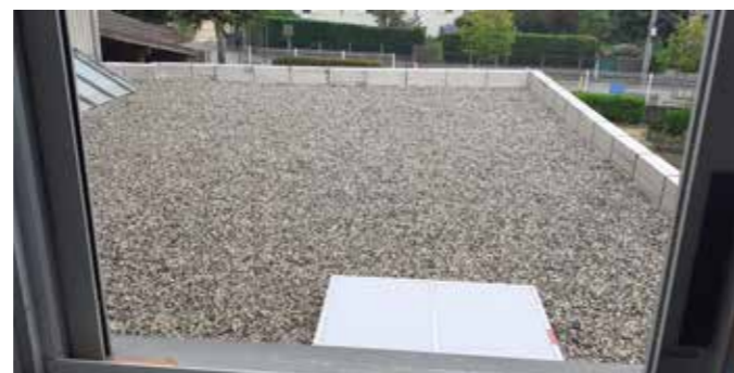
> Toiture terrasse école de Ciers
