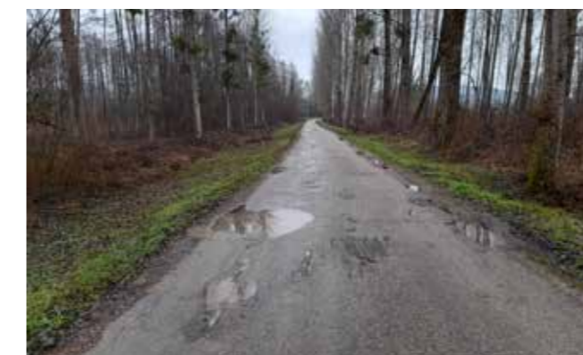
> Route de Granieu avant travaux
