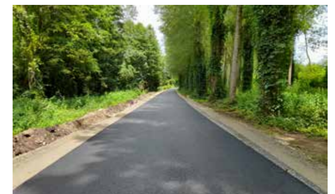
> Route de Granieu après travaux
